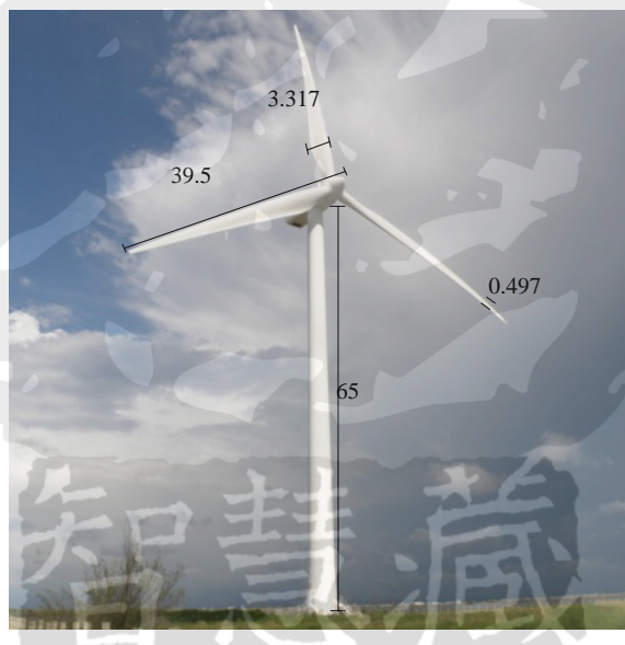
圖六 V80 風機尺寸標註圖(單位：m)
